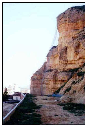
Malla de protección y muro de contención frente a los desprendimientos en el cerro del castillo de Monzón.
